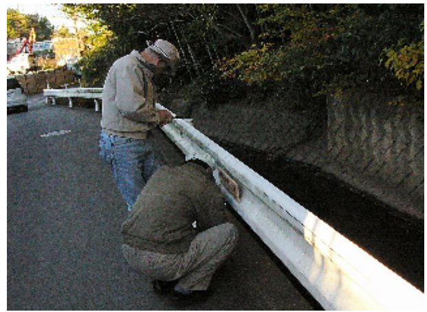
<ガードレールに取り付ける作業>
