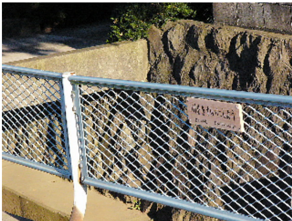
<フェンスに設置されたプレート>
