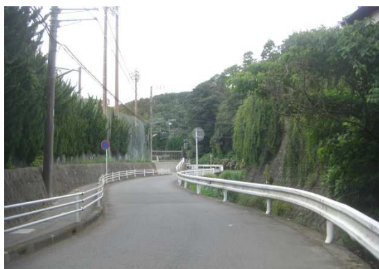
道路両側のガードレールの雑草も守備範囲。除草すれば見た目にも気持ちが良い(2013.7.13 (土))
