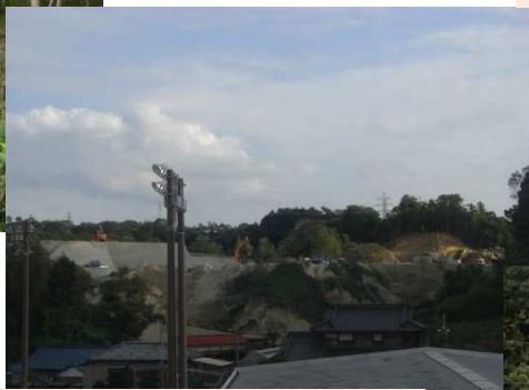
流域内で進行中の大規模宅地造成。樹木伐採によって大雨による下流域の水位上昇が懸念される。
