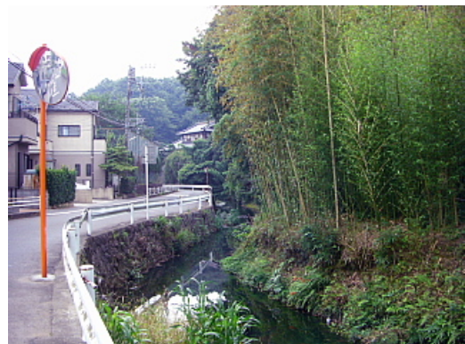
清掃後のよへい屋敷谷戸前の関谷川
