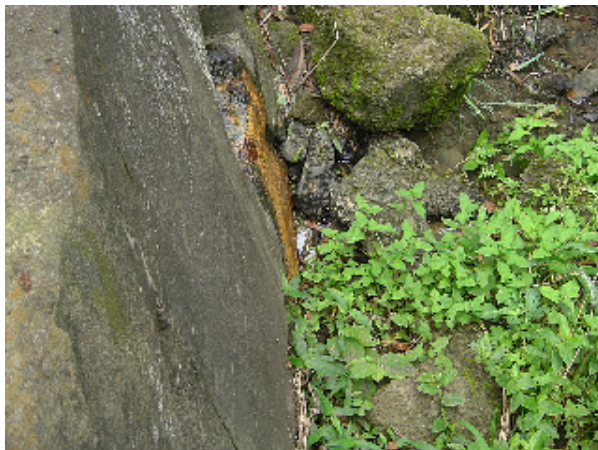
<壁の暗渠から出る錆び色の排油>
